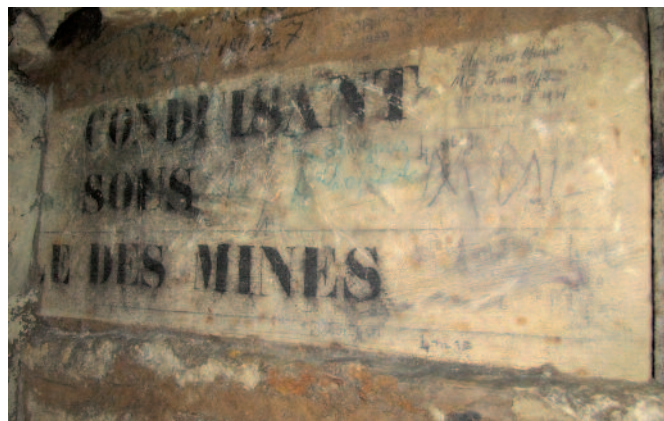
Photo de la plaque non gravée "[Chemin] conduisant sous [l'Éco]le des Mines", masqué depuis en partie par un mur construit par l'administration de France Telecom pour supporter au dos des câbles téléphoniques.
